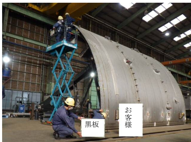
写真 1.円弧型の寸法検査状況
