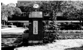
H21年度にA2棟の耐震補強・リニューアル工事が完成しました
